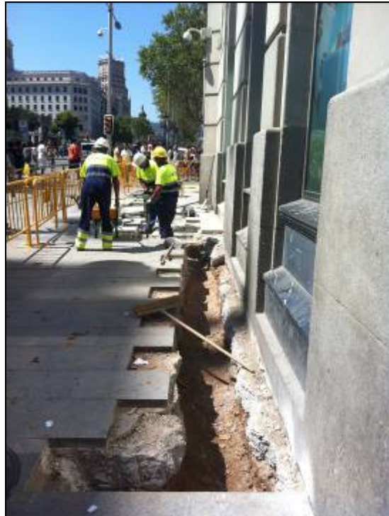
5. Inici dels treballs de la rasa.
