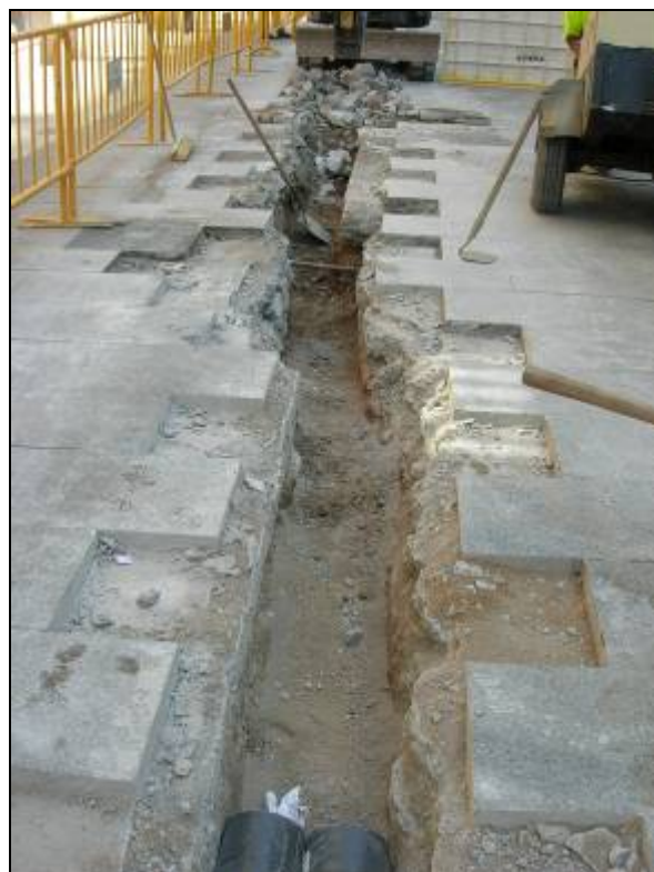
20. Tram de rasa buidat, presència de diferents serveis urbans.
