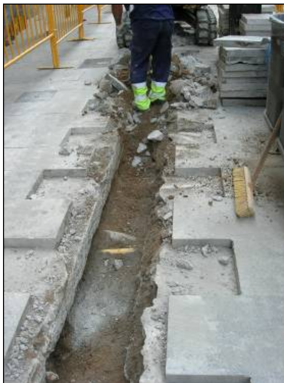
18. Buidat de la rasa, s'aprecia la presència d'un servei de gas.
