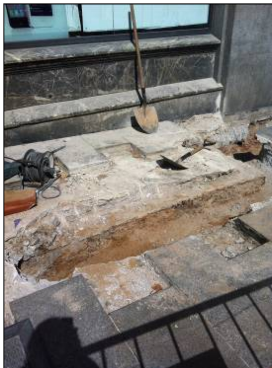
6. Treballs de buidat de la rasa.
