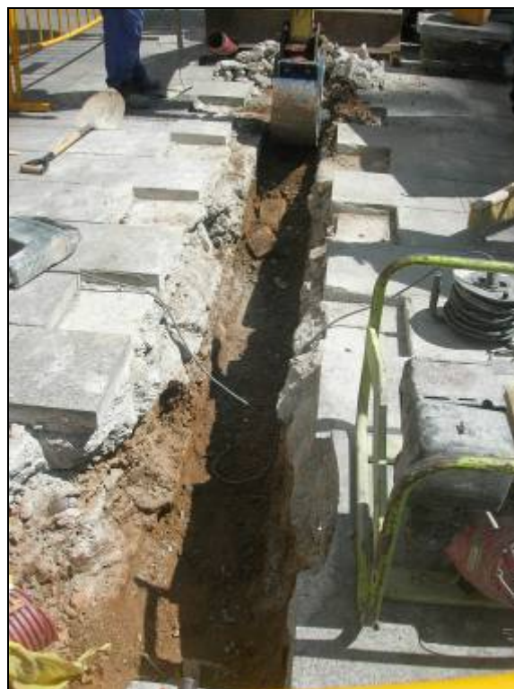
12. Buidat de la rasa de forma mecànica davant el nº44 de Portal de l'Àngel.
