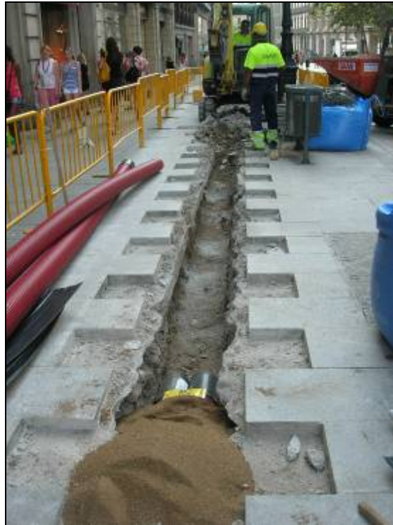
17. Buidat de la rasa simultani a la col·locació dels tubs.
