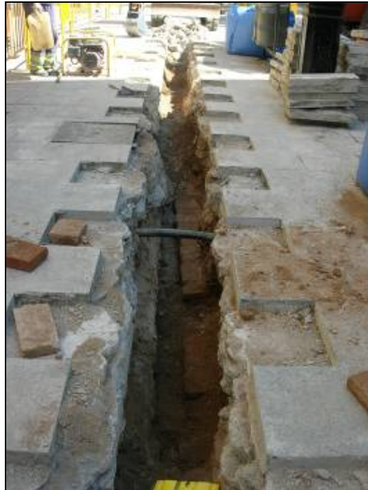
25. Presència de diversos serveis urbans al llarg del traçat de la rasa.
