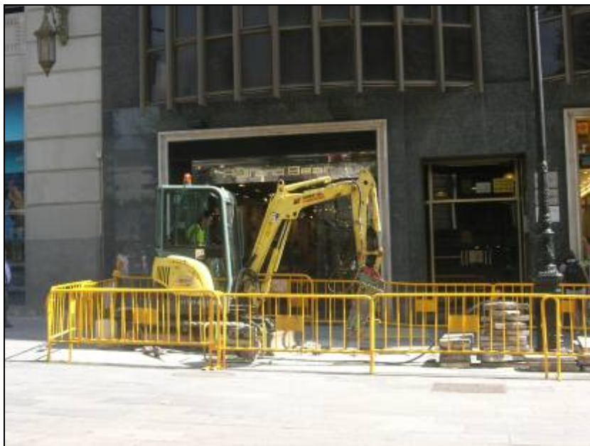
10. Buidat de la rasa de forma mecànica.
