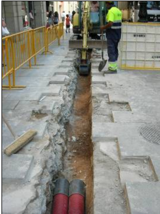
21. Buidat mecànic de la rasa.
