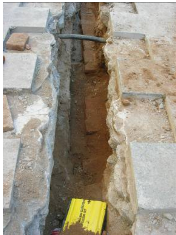
24. Tram de rasa on s'observa la presència d'un servei elèctric dins el traçat.
