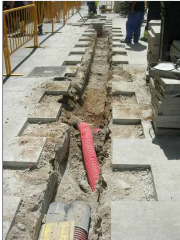
19. Presència de serveis elèctrics a poca profunditat.
