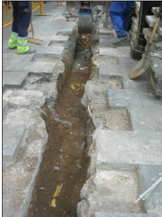
13. Buidat e la rasa de forma mecànica.
