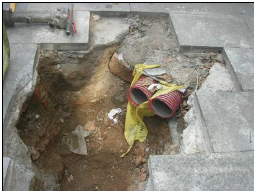
14. Col·locació dels tubs simultàniament al buidat de la rasa.
