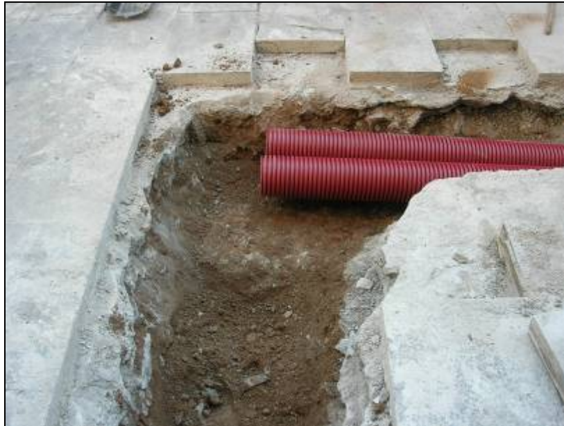
29. Treballs finals de buidat de la rasa.
