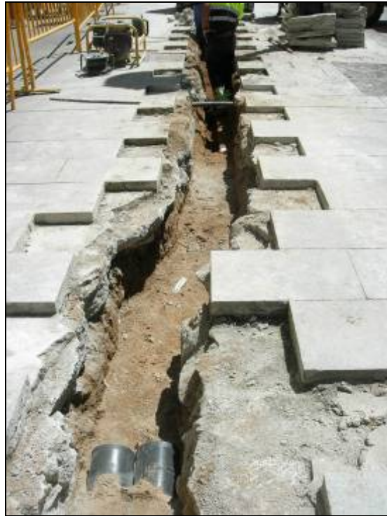
23. Rasa buidada amb la presència de diferents serveis urbans.
