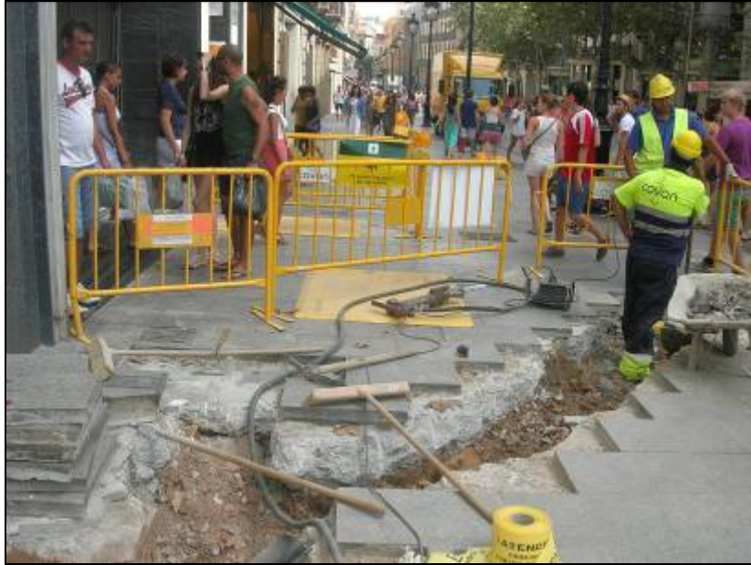
9. Inici dels treballs a l'avinguda del Portal de l'Àngel.
